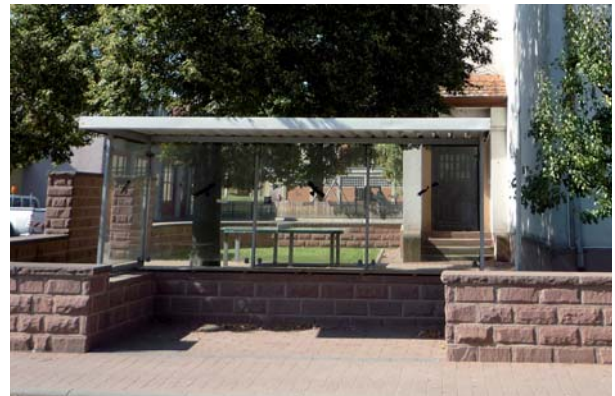
Bushaltestelle am Schulgebäude in Remlingen
