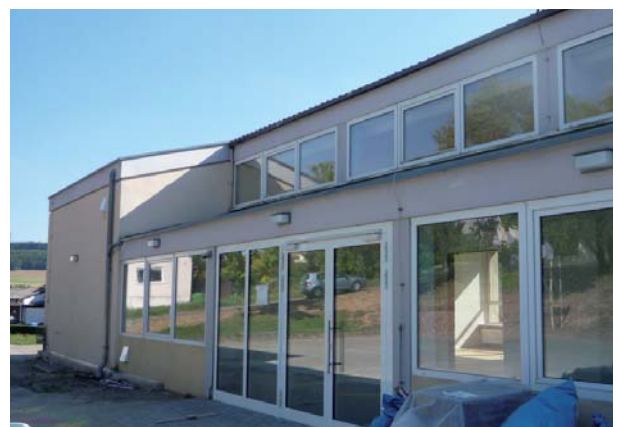
Schulhaus in Holzkirchen während des Umbaus im September 2013
