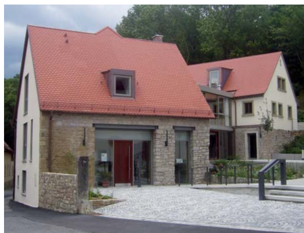
Beispiel Seniorenwohnen in Reichenberg, Sanierung eines leerstehenden Hofes
